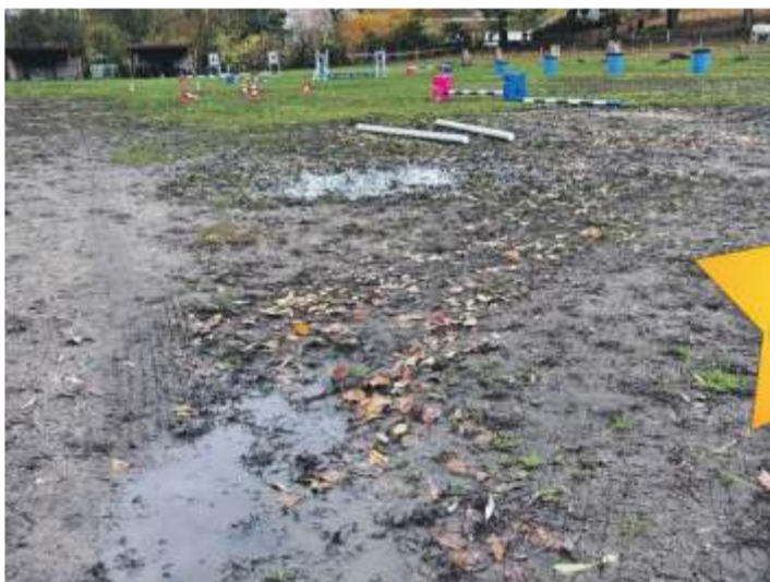
Erneuerung der Tragschicht für den Reitplatz, zahlreiche Löcher und Unebenheiten. Foto: privat
